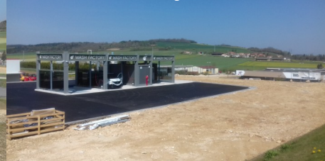
Nouvelle station de lavage tout véhicules
